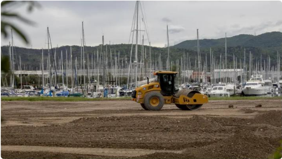
LE RECENTI OPERE PRELIMINARI PER L'IMPIANTO DI CARBURANTE A IDROGENO (KATIA BONAVENTURA)
